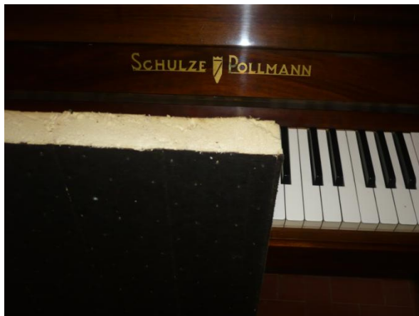
Foto 3: Aula 3: precedente finestra vetrata sostituita da pannello poliuretano e dettaglio del pannello. Il medesimo pannello è stato utilizzato a chiusura delle aperture presenti nelle altre aule.
