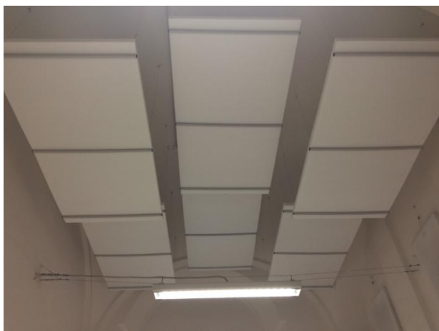
Foto 19: Aula 5: pannelli in fibra di poliestere sospesi
