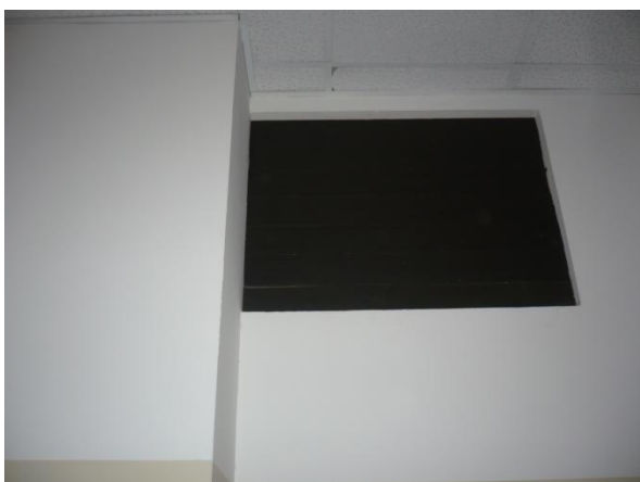
Foto 3: Aula 3: precedente finestra vetrata sostituita da pannello poliuretano e dettaglio del pannello. Il medesimo pannello è stato utilizzato a chiusura delle aperture presenti nelle altre aule.
