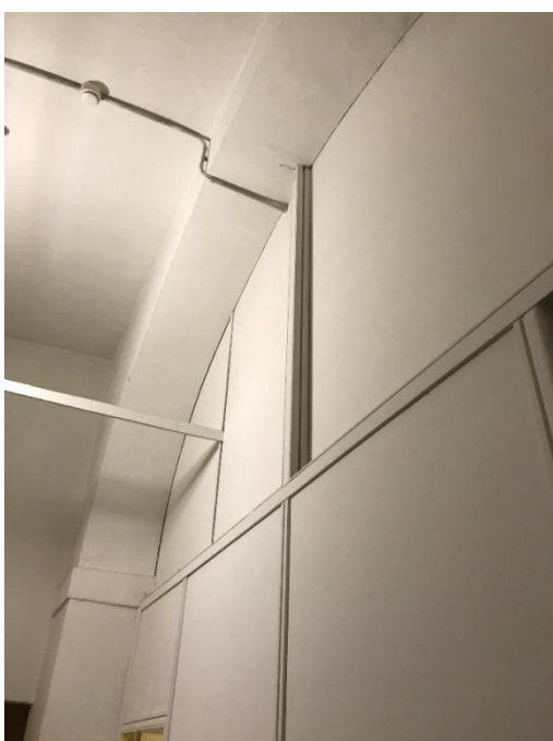
Foto 16: Aula 4: parete in legno verso corridoio lato corridoio
