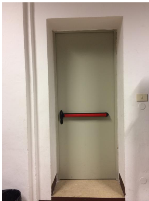
Foto 22: Porta REI120 aula 5 lato aula
