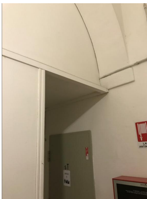
Foto 17: Aula 4: parete in legno verso corridoio lato corridoio
